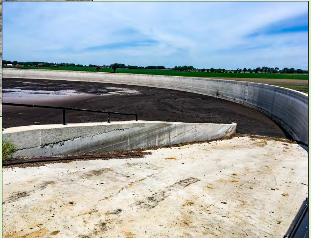
I en 75.000 m 3 gylletank er der også plads til en nedkørsel, så udgravning af bundfald lettes
